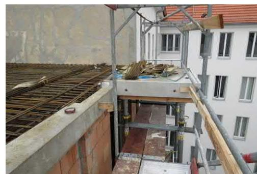
Befestigung der Balkone mittels Isokörben
