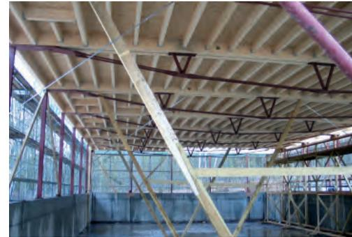
Montage der OSB-Dachkonstruktion
