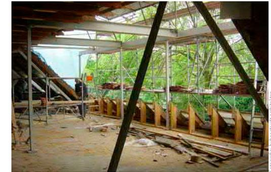
Einsetzen der Stahlkonstruktion für die Dachgaube
