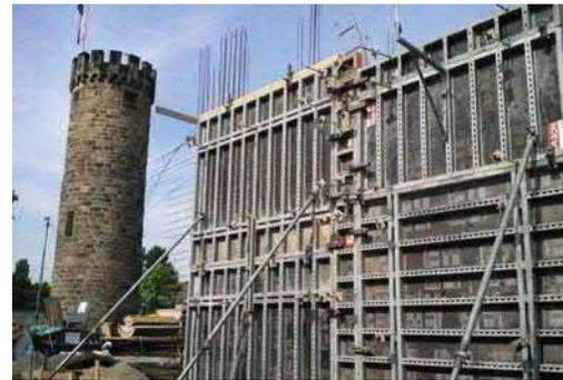
Schalung der Wände des Erdgeschosses
