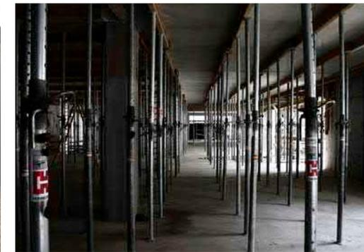
Stützen der Erdgeschossdecke während der Bauarbeiten
