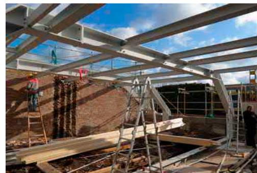
Stahlgerüst für die neue Dachkonstruktion
